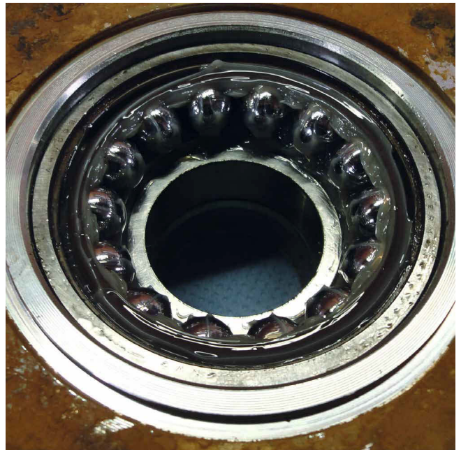
Nach Demontage des Lagers wurde kein Schmutz im Lagerinneren oder im Fett gefunden.
